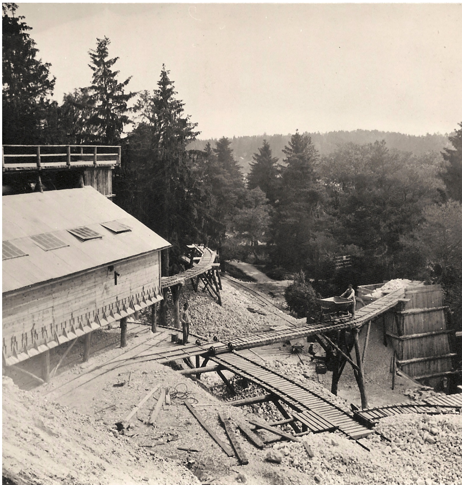
Sorteringsverket vid Ytterby pegmatitbrott med raden av tappfickor. Bilden publicerad med tillstånd av Österåkers Hembygds- och Fornminnesförening.
